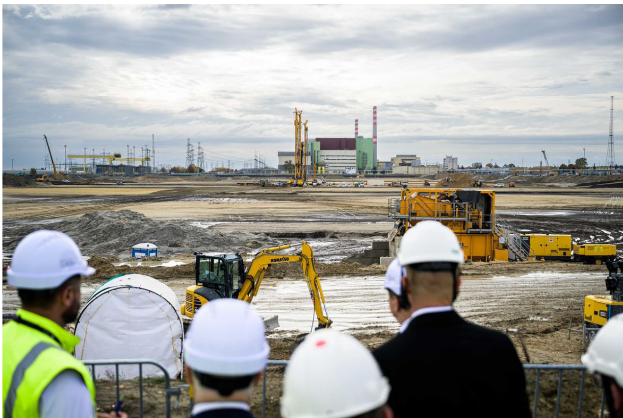
Строительная площадка АЭС «Пакш-2»
